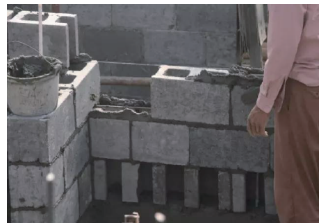
图 3-3 硅酸盐砌块墙体
