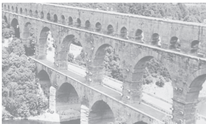
法国噶尔德桥下的导水渠
