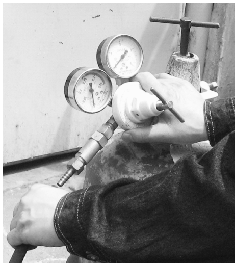
图 3-15 安装乙炔胶管
