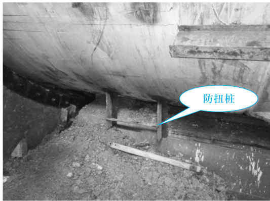
图 3-68 始发基座防扭转装置
