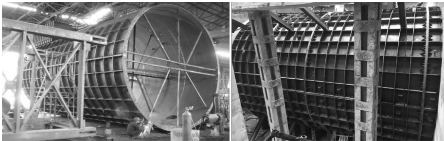
图 3-91 套筒安装实例图
