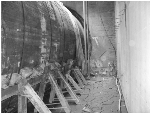
图 3-69 始发基座侧向支撑
