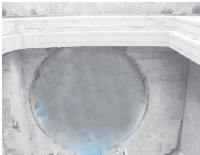
图 3-49 竖井井壁预埋环形钢板
