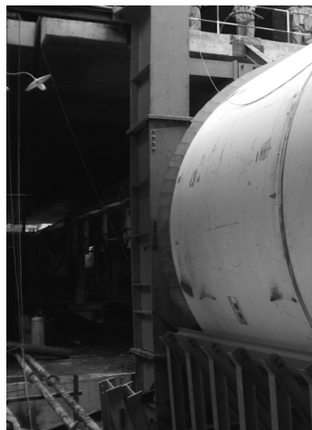
图 3-62 反力架的加固
